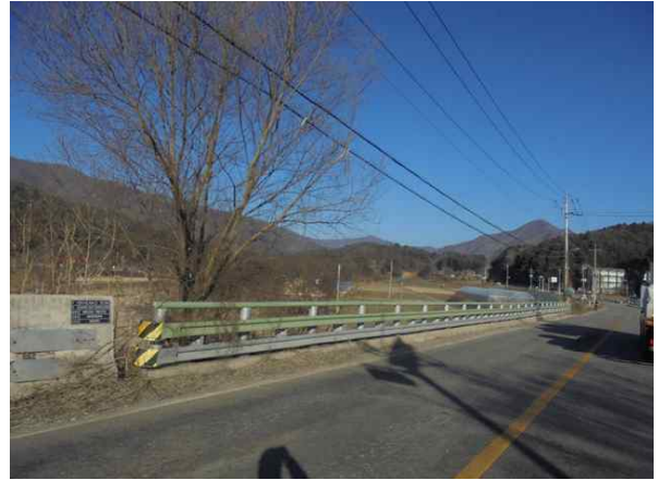
난간 및 연석 전경
