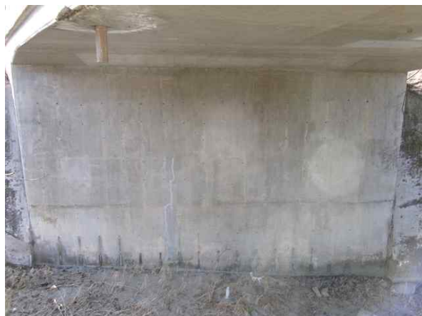
교대 전경 (A1)
